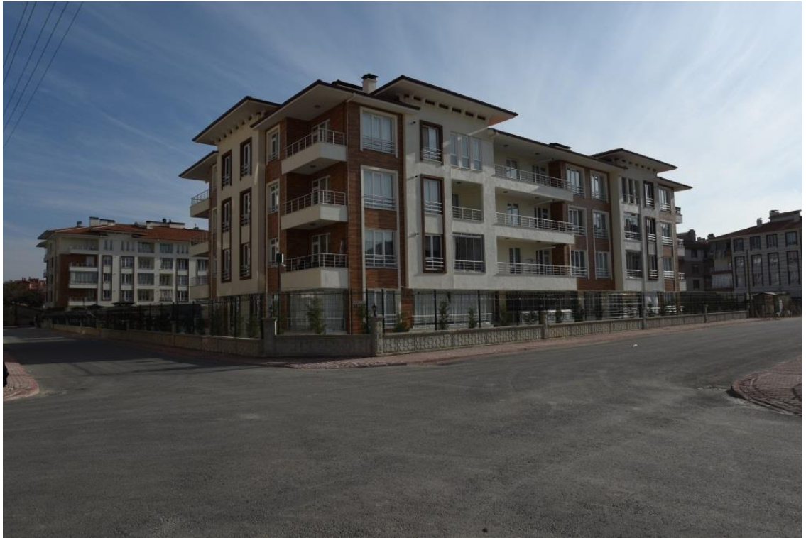
Gümüştül Konutları (Çetnevir Sokak görünümü)
