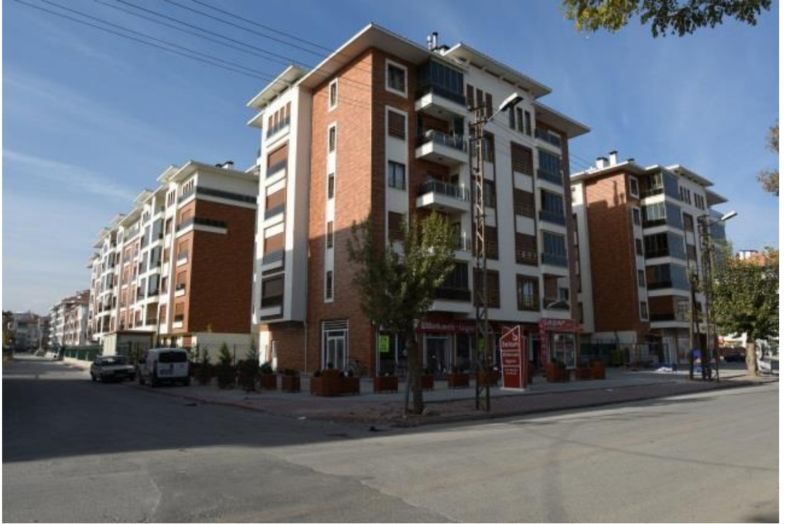
Araplar Caddesi'den görünümü (Güney - Doğu Cephesi)
