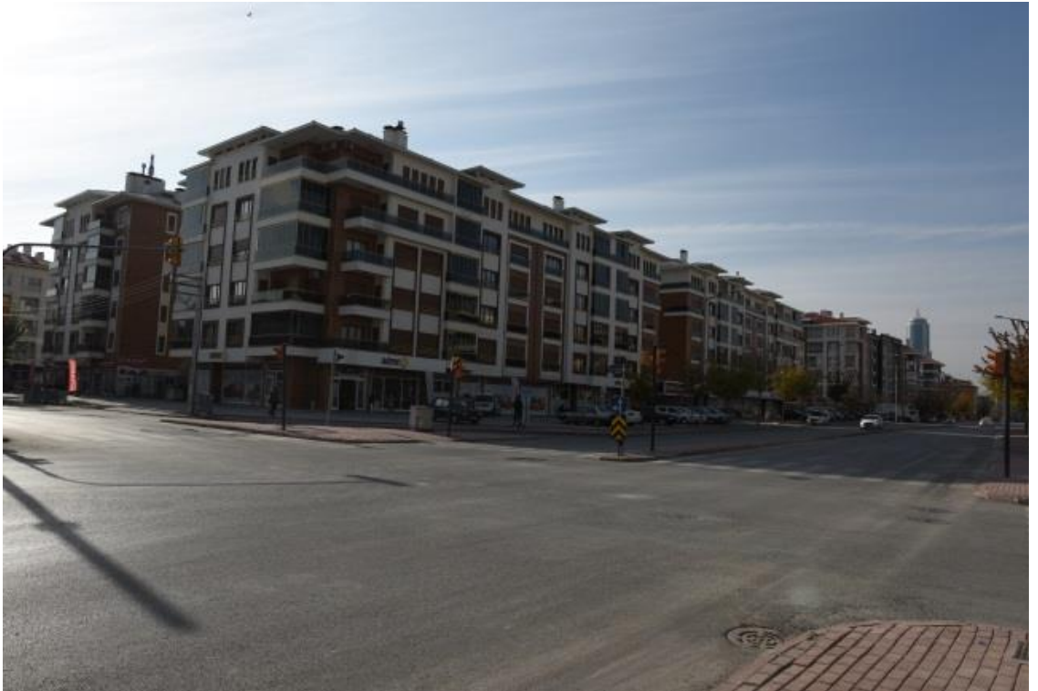
Ali Ulvi Caddesi'den görünümü (Kuzey - Doğu Cephesi)
