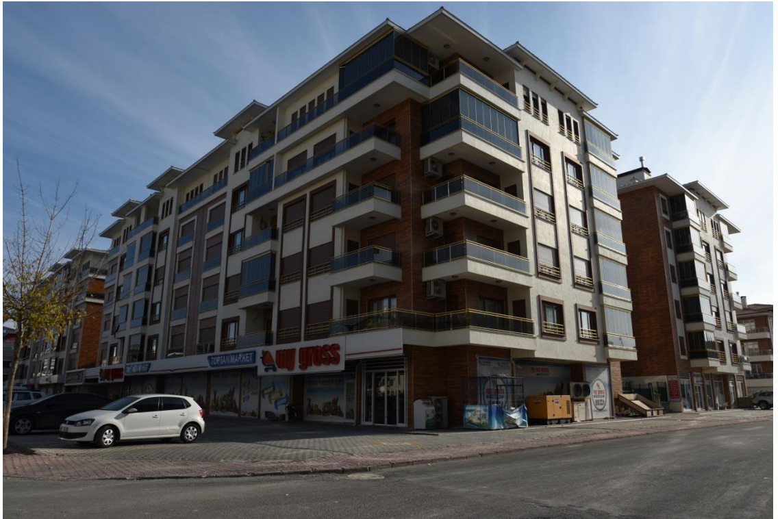
Çetnevir Sokak görünümü (Kuzey - Batı Cehesi)
