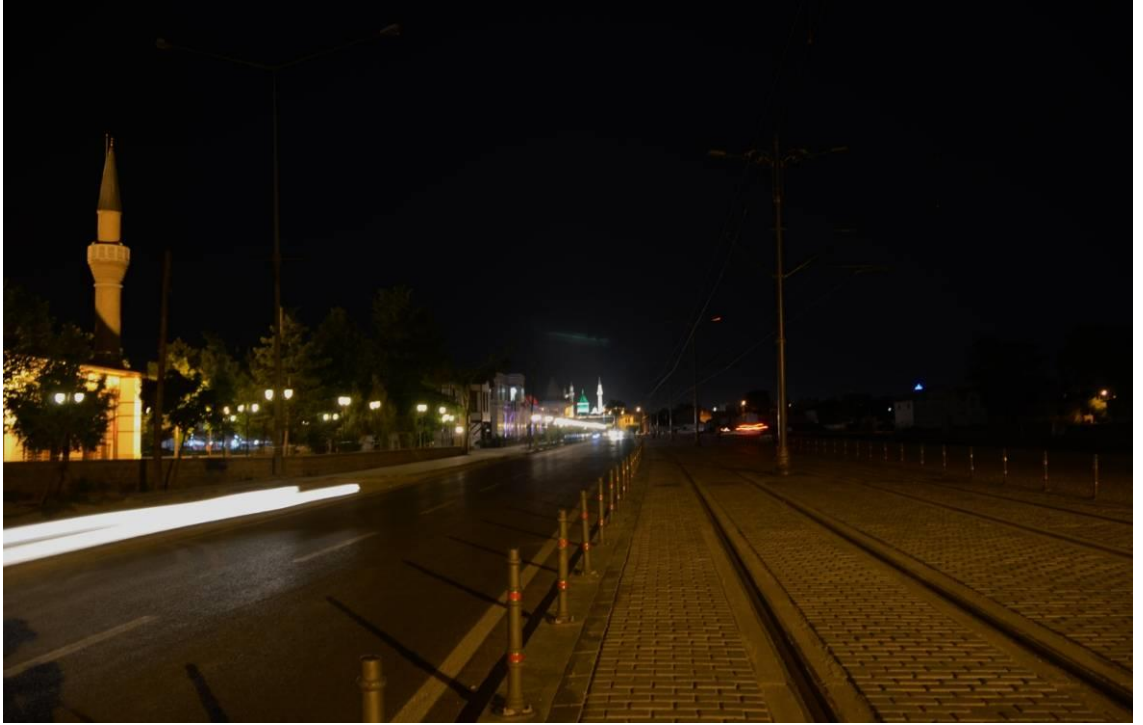
Şekil 5.29: Tramvay Yolu Aydınlatması Gece Görünüşü
