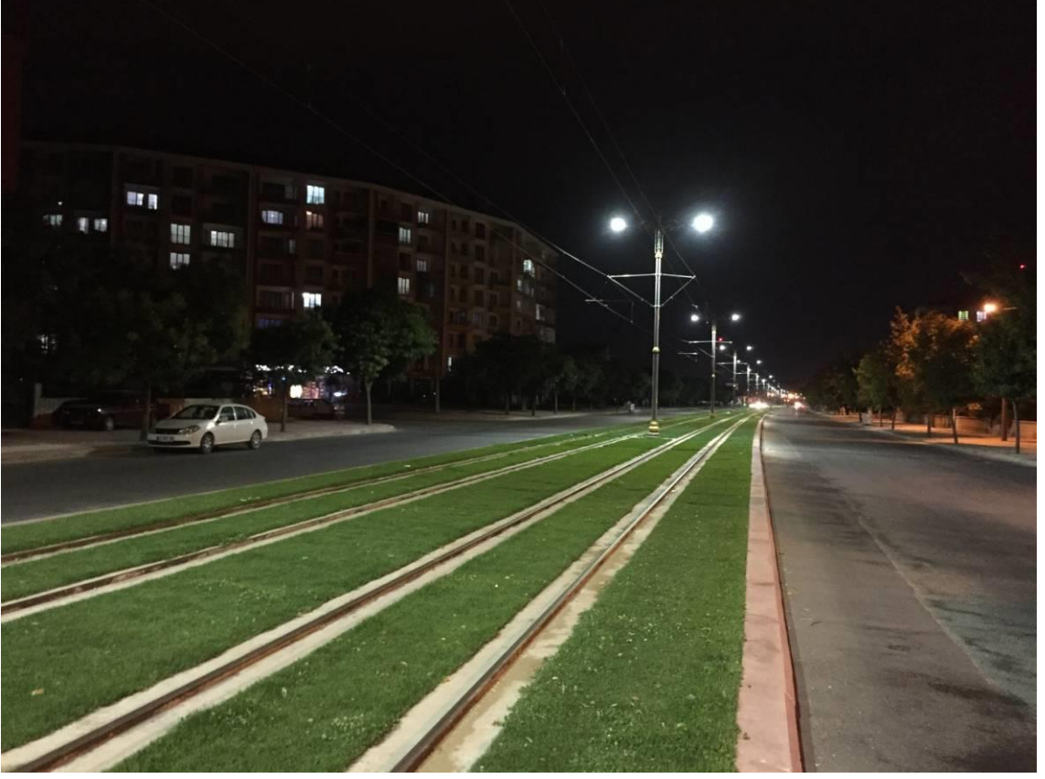
Şekil 5.28: Tramvay Yolu Aydınlatması Gece Görünüşü
