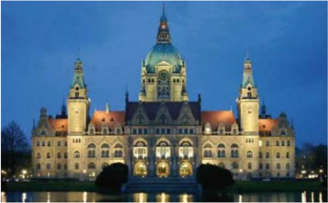
Şekil 3.9: Örnek dış cephe aydınlatma uygulaması (28) (32)
