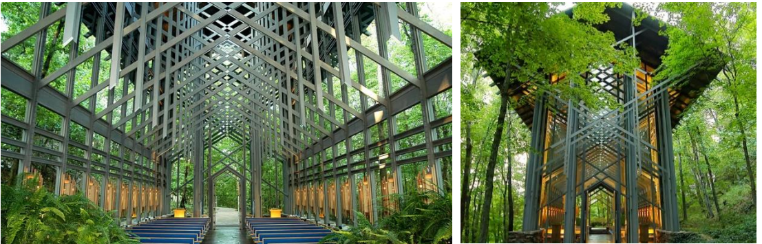
Şekil 2. 7: Thorncrown Şapeli, Arkansas/USA (1980), [URL7]
