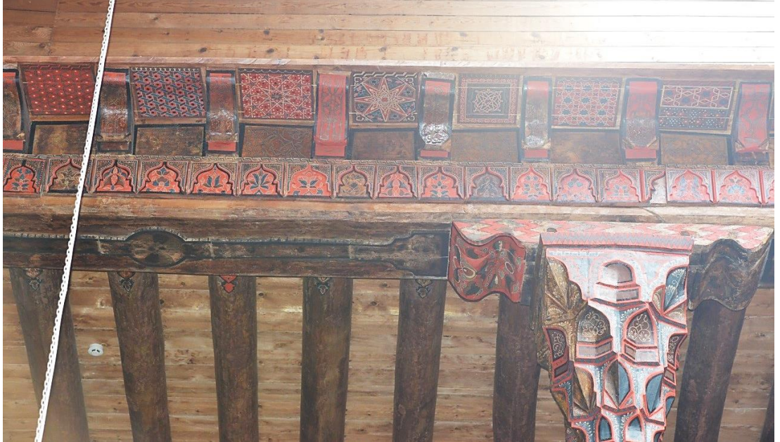
36: Eşrefoğlu Süleyman Bey Camii, Tavan Kirişi Arası ve Yan Yüzlerin Kalemîşi Nakış Detayları
