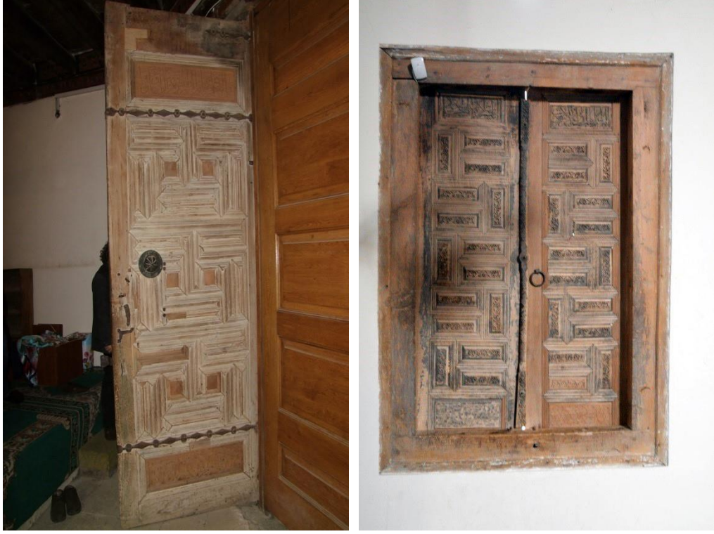
35: Eşrefoğlu Süleyman Bey Camii, (sol) Kuzeydoğu Ahşap Giriş Kapısı, (sağ) Güneybatı Pencere Kanadı
