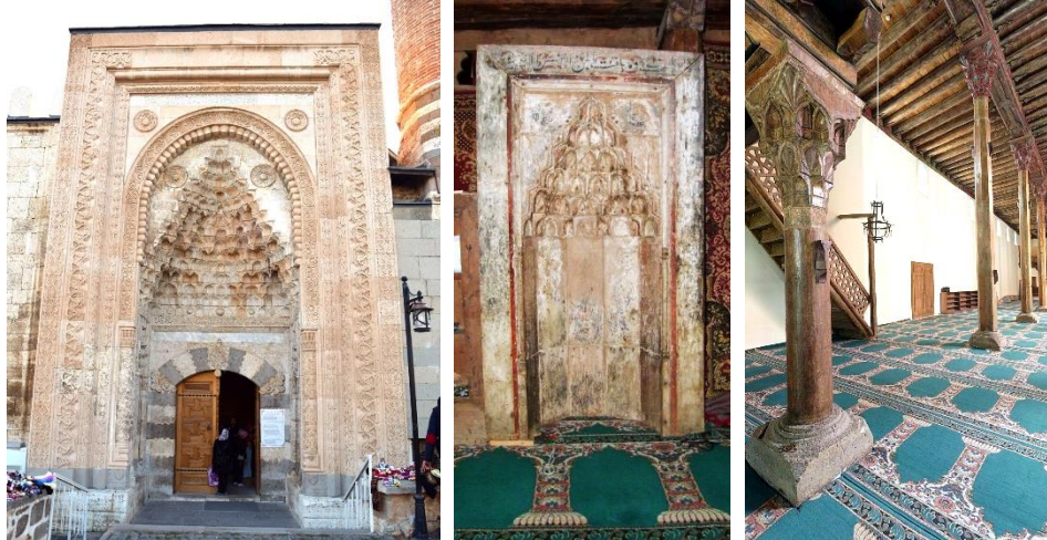
Şekil 4. 22: Eşrefoğlu Cami, (sol) Taç kapısı, (orta) Son cemaat mahalindeki ahşap mihrabı ve (sağ) Harimin batı cephesindeki taşıyıcı sütunlar
