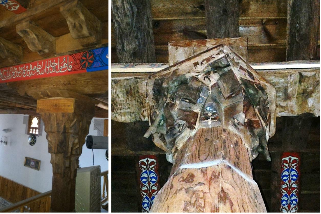
46: Köşk Camii, (sol) Mahfil Önü Ahşap Sütun Başlığı ve (sağ) Mukarnas detayı
