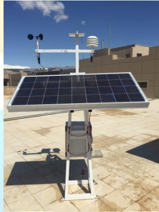
Şekil 3: Adıyaman terminal ölçüm istasyonu
