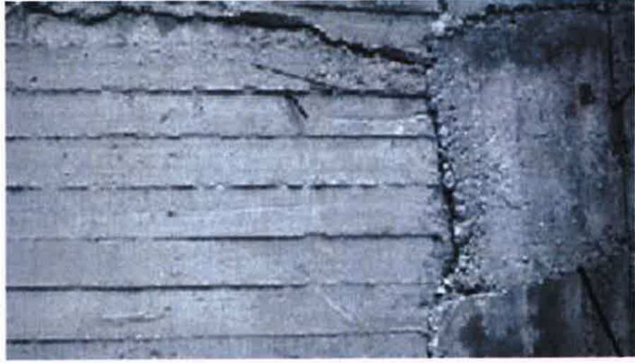
Şekil 2.3. Kolonda oluşturulan soğuk derz
