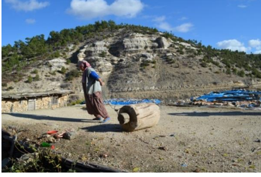
Şekil 3. 59. Yuvak ile çatı toprağının sıkıştırılması
