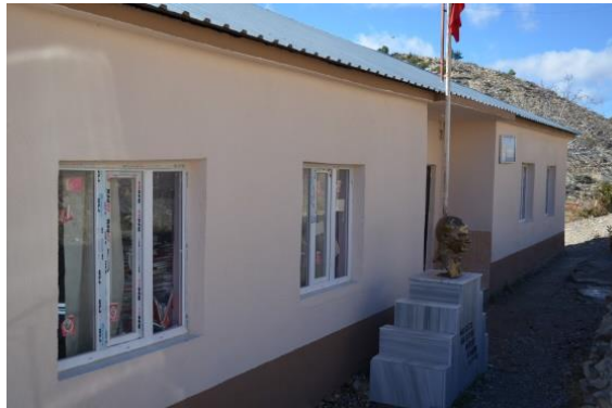
Şekil 3. 23. Yeni okul binası
