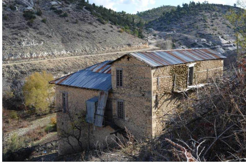
Şekil 3. 61. Köyde kırma ve beşik çatının birlikte kullanıldığı bir ev
