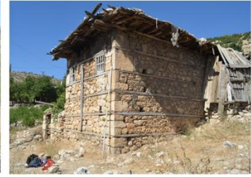
Yapı köşelerinde kullanılan kesme taşlar
