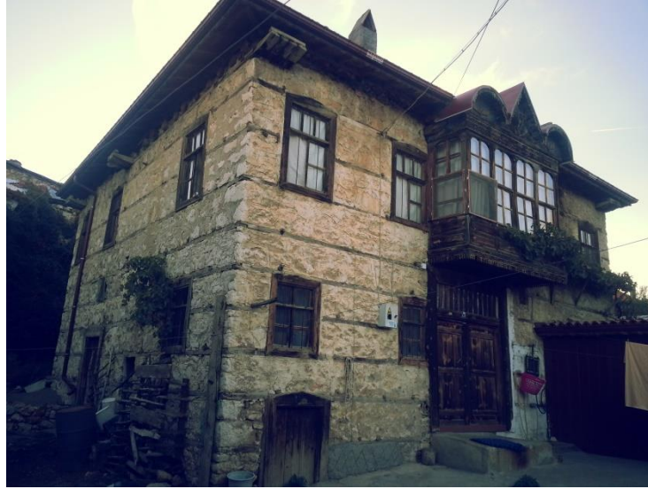
Şekil 2. 21. Taş ve ahşabın birlikte kullanımı, Beyşehir 2015.
