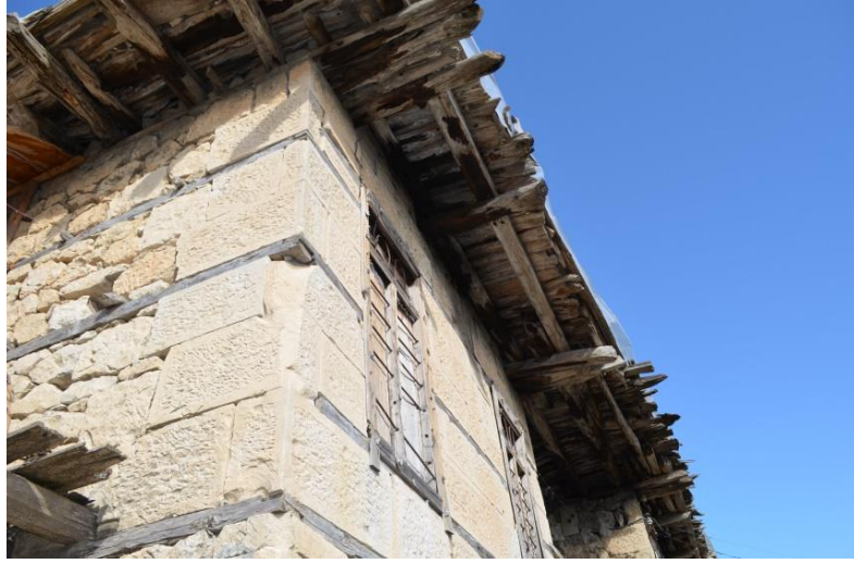
Şekil 3. 63. Kesme taş kullanılan bir cephe kesiti
