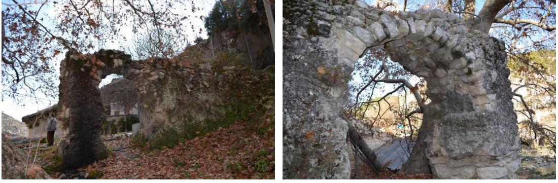
Şekil 3. 9. Su kaynağının yanındaki Roma Dönemine ait bir kemer kalıntısı
