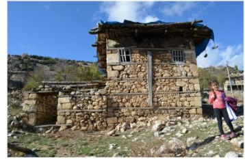
Sağ Yan cephe
