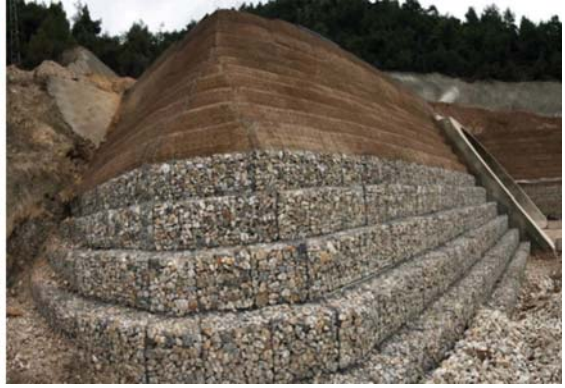
Şekil 14 - Gabionun köprü ve tünel yaklaşım dolgusu olarak kullanımı (TeknoÇevre web sayfası, 2010)
