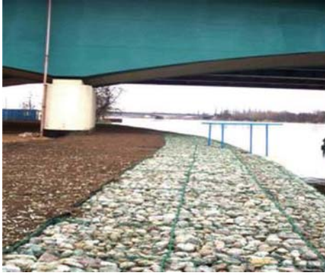
Şekil 14 - Gabionun köprü ve tünel yaklaşım dolgusu olarak kullanımı (TeknoÇevre web sayfası, 2010)
