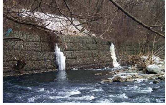
Şekil 12 - Gabionun sediment tutulmasında (Baltimore) kullanımı (Maccaferri, 2010)
