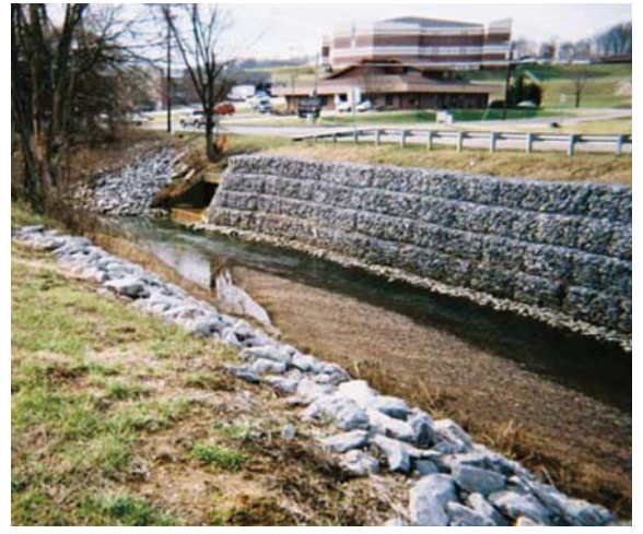
Şekil 9 - Şev düzenlemesi (Missouri) uygulaması (Maccaferri, 2010)
