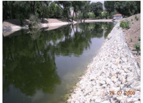
Şekil 11 - Eskişehir Porsuk Çayı şilte gabion dere yatağı ıslahında kullanımı (Tekno Maccaferri web sayfası,2008)
