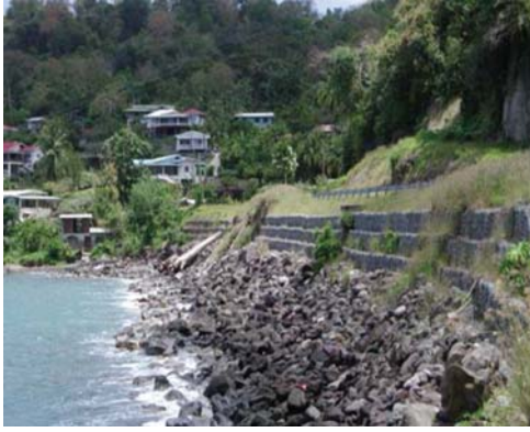
Şekil 13 - Gabionun sahil korumada (Grenada) kullanımı ve teknik çizimi (Maccaferri, 2010)
