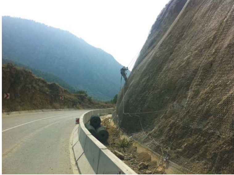
Şekil 7 - Bozüyük - Mekece Yolu Şevde Kaya ve Taş Düşmelerine Karşı Çelik Grid Uygulaması (Tekno Maccaferri web sayfası, 2011)
