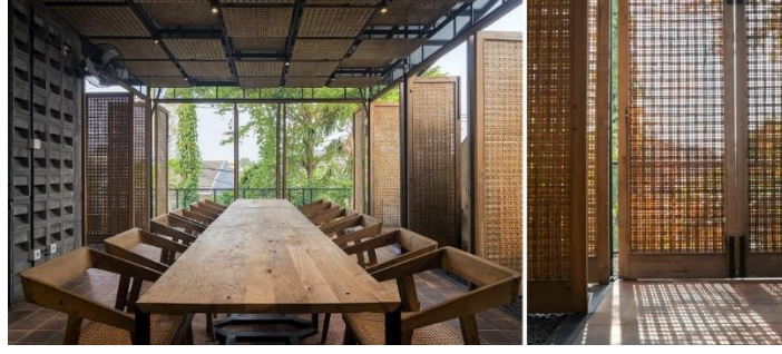
Şekil 38. Andyrahman Mimarlık Ofisinin ikinci katında yer alan toplantı odası ve nefes alan duvar uygulaması
