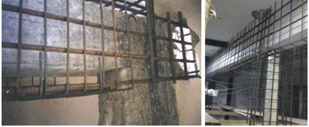
Şekil 57. Kiriş mantolamasında donatı sürekliliğinin komşu açıklıklarda sağlanması
