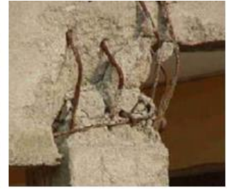
Şekil 25. Birleşim bölgesinde etriye eksikliği nedeniyle oluşan hasar biçimi
