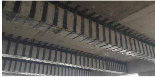
Şekil 61. Kirişlerin çelik levha ile güçlendirilmesi
