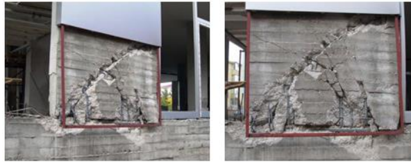
Şekil 40. Kesme dayanımının aşılması
