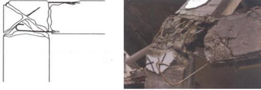
Şekil 26. Birleşim bölgesinde kiriş boyuna donatılarının kenetlenme boyunun yetersiz olması nedeniyle sıyrılmaya başlamış bir kolon-kiriş birleşim bölgesinin teknik çizimi ve fotoğrafı.
