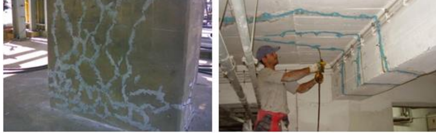
Şekil 53. Epoksi reçinesi ile onarım
