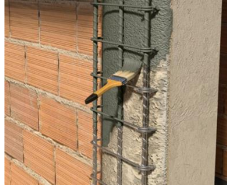
Şekil 54. İki yüzey arasındaki aderansı arttırmak için epoksi sürülmesi
