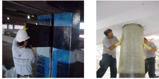
Şekil 69. Kolonun lifli polimer (LP) ile sarılması
