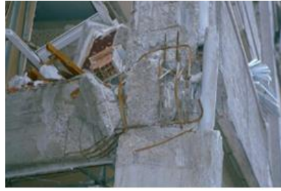
Şekil 25. Birleşim bölgesinde etriye eksikliği nedeniyle oluşan hasar biçimi
