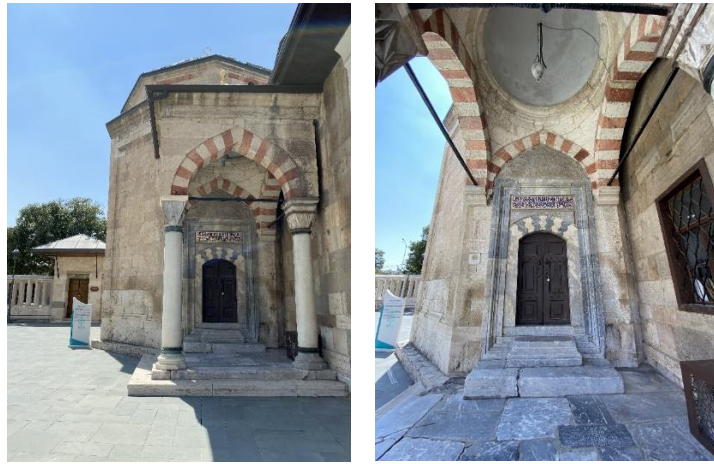
Şekil 36. Hürrem Paşa Türbesi
