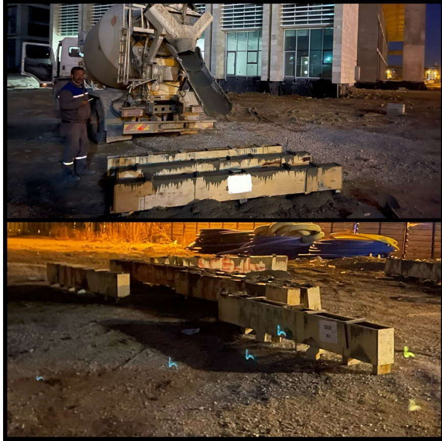
Şekil 30. Beton dökümü
