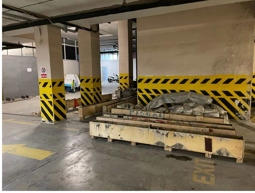
Şekil 29. Beton dökümüne hazır kalyplar
