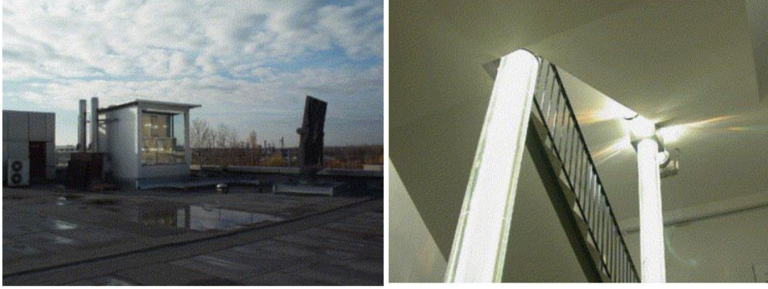
Şekil 36 Heliostat, Berlin, Almanya'daki Semperlux binasının tepesinde
