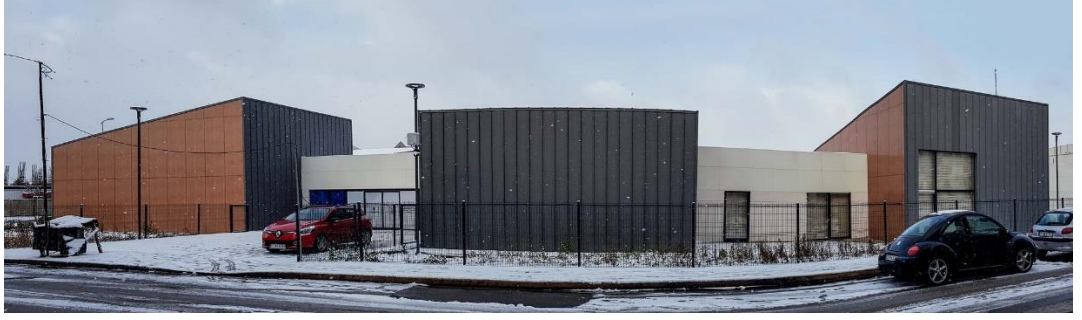
Şekil 56.Sancaktepe İşitme ve Konuşma Engelliler Eğitim ve Rehabilitasyon Merkezi dış mekandaki kütleli hareketlilik
