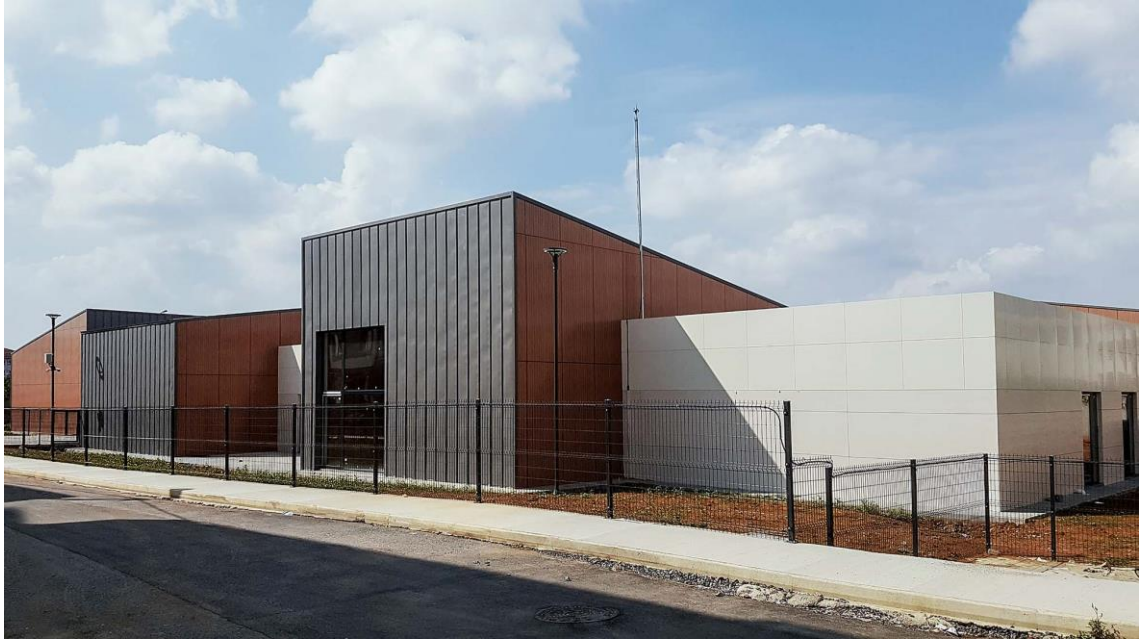
Şekil 50.Sancaktepe İşitme ve Konuşma Engelliler Eğitim ve Rehabilitasyon Merkezi dış genel görünüm
