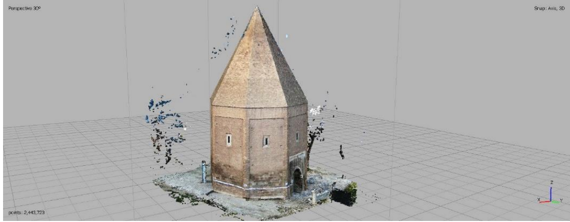
Şekil 57. Agisoft Metashape – Temizlenmiş yoğun nokta bulutu (2443723 nokta) Yoğun nokta bulutunun 2443723 noktaya indirgenip hassasiyetinin artırılmasının ardından yüzey atama işlemi yürütülmektedir. Bu işlem için program arayüzüne girilen değerler Şekil 58 ‘de gösterilmektedir.
