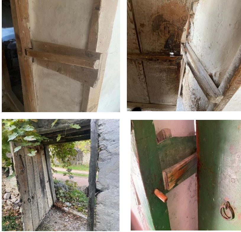
Şekil 84. Kapılardaki çeşitli kilit sistemleri
