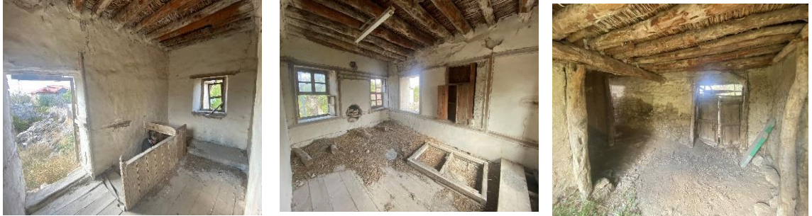
Şekil 77. Hasan Gül Evi iç mekan fotoğrafları
