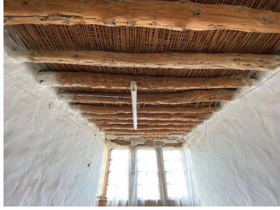
Şekil 79. Sofadaki ahşap kirişlemeler
