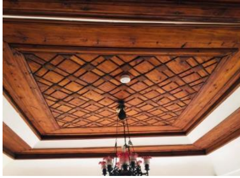
Şekil 17. Safranbolu Emir Hocazade Ahmet Beyler Konutu'nun gerçek künde-kari tekniği uygulanmış baş oda tavanı
