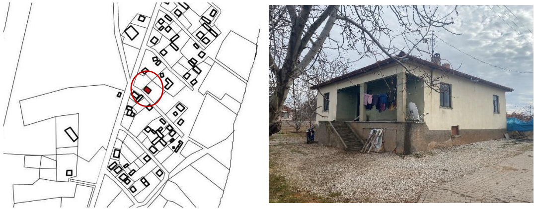
Şekil 95. Şeref Aydoğan Evi'nin Yeni Gölkaşı yerleşimi içerisindeki konumu ve sokaktan görünümü
