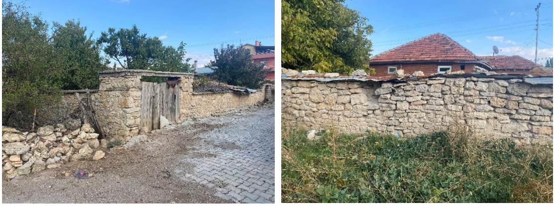
Şekil 82. Bitişleri farklı malzemeler kullanılarak sağlamlaştırılmış bahçe duvarları
