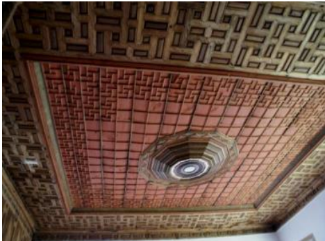
Şekil 18. Kaymakamlar Evi'nde uygulanmış taklit künde-kari tekniği tavan örneği
