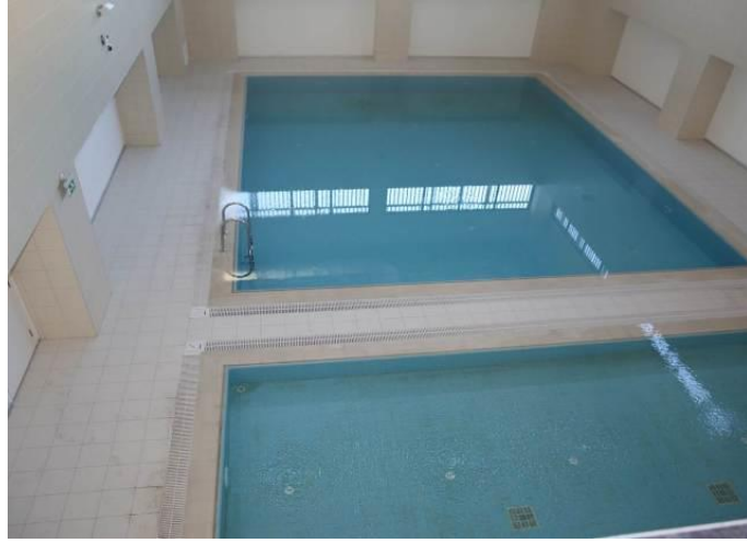
Şekil 43. SOBE Hidroterapi Alıştıırma Havuzu
