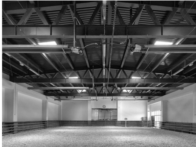
Şekil 35. SOBE Kapalı Manej Uzay Çatı Uygulaması
