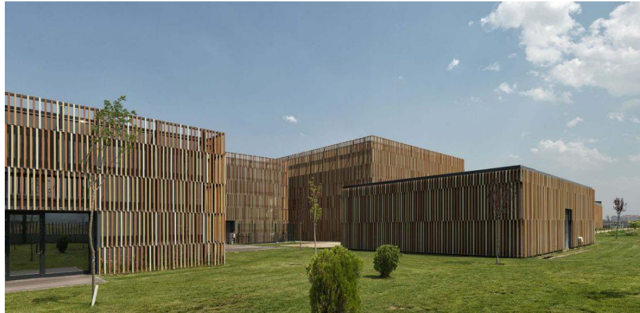
Şekil 19. SOBE Vakfı Terra-cotta Uygulaması
