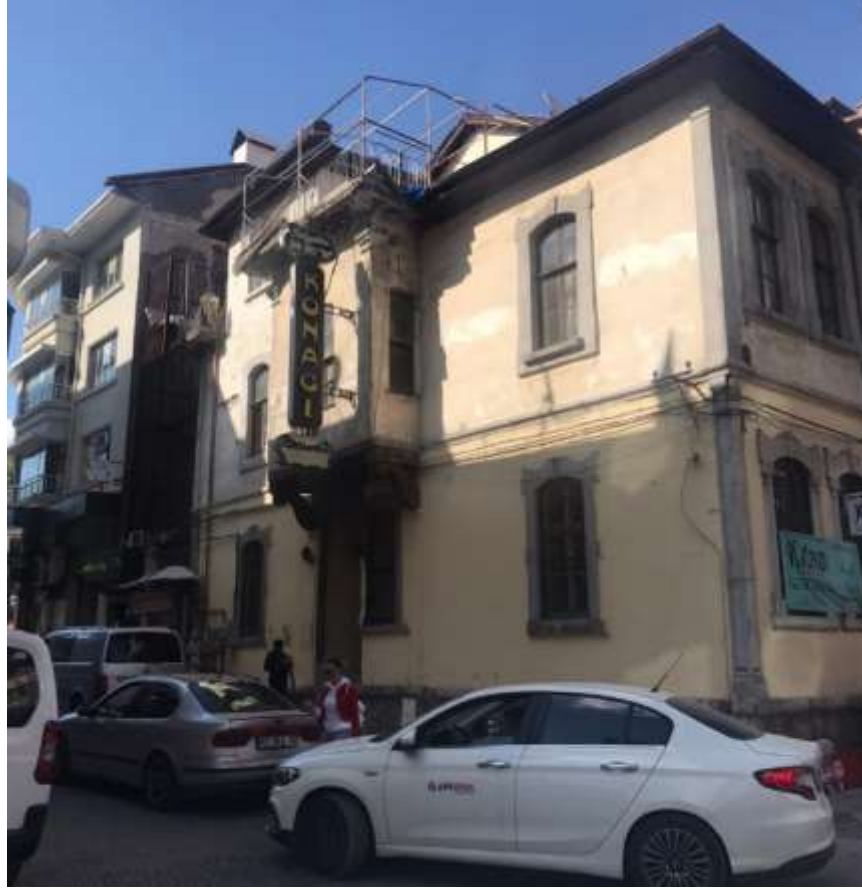
Şekil 15: Arapoğlu Kosti Evi Batı cephe görünüş ve plaster sütun
