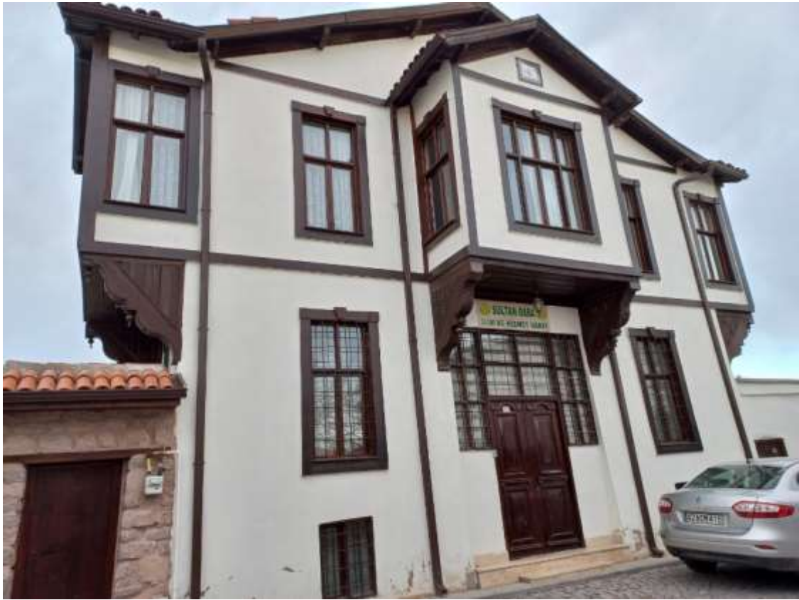
Şekil 46: Ahmet Efendi Konağı ön (kuzeybatı) cephesi
