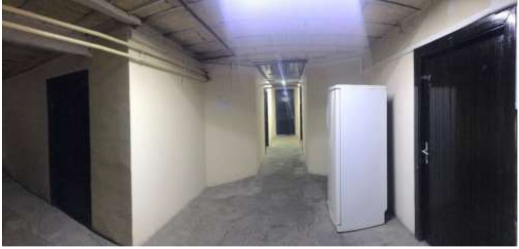
Şekil 20: Atatürk Evi Müzesi bodrum kat holüne güney cepheden bakış
