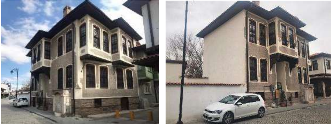
Şekil 43-44: Eğitim Vakfı Evi'nin sağ ve sol yan cephelerinden ön cepheye bakış
