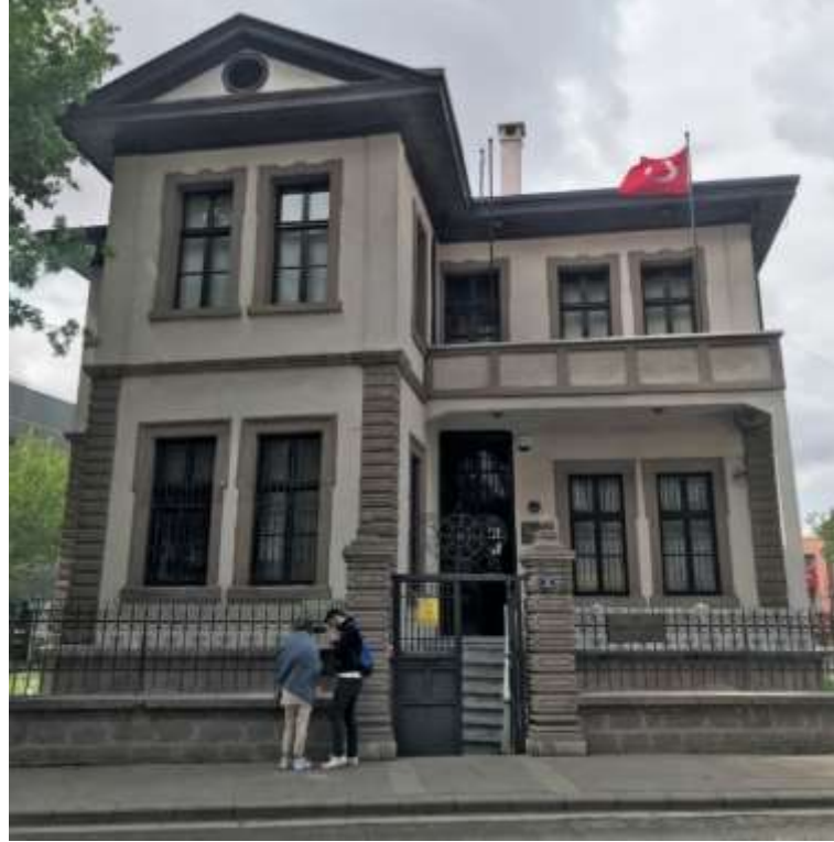
Şekil 25: Atatürk Evi Müzesi güney cephe (ön) görünüş
