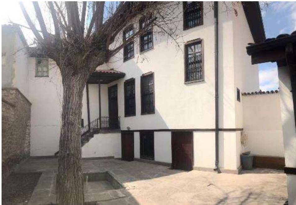
Şekil 45: Eğitim Vakfı Evi bahçeden konutun güneydoğu cephesine bakış
