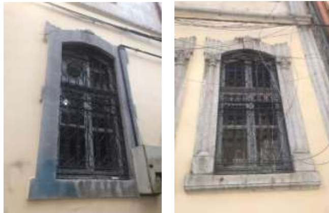
Şekil 13-14: Arapoğlu Kosti Evi zemin kat batı ve güney cephedeki pencere detayları
