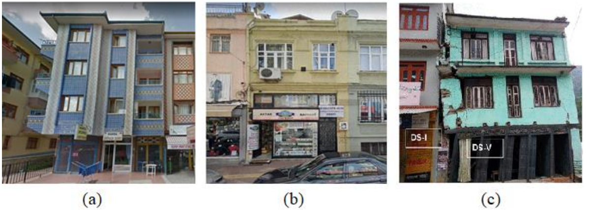
Şekil 2. (a):Tek cepheden bitişik nizam bina cephe görüntüsü. (b):İki cepheden bitişik nizam bina cephe görüntüsü. (c):Tek cepheden bitişik nizam bina cephe görüntüsü.
