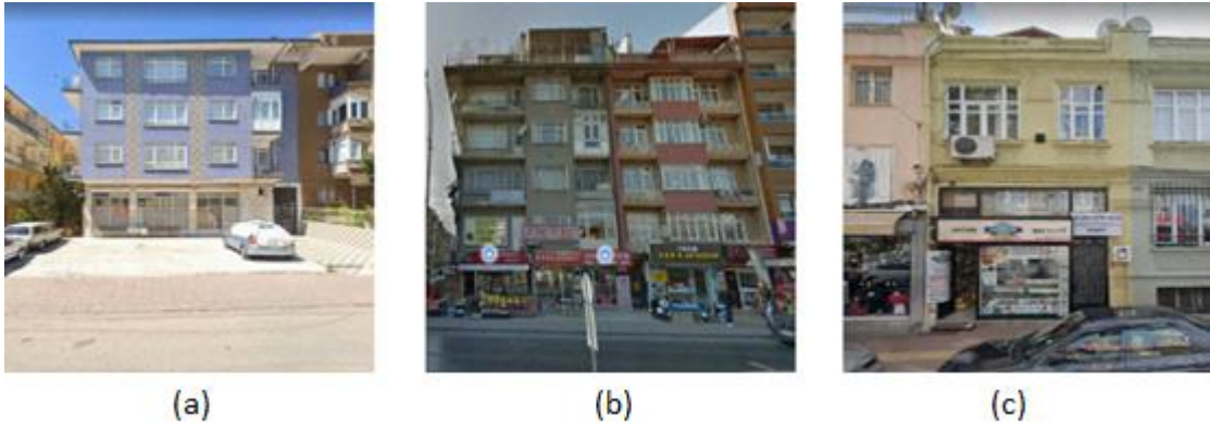
Şekil 16. Bitişik nizam durumu olan binalar. (a): 3 katlı tek cepheden bitişik nizam bina. (b): 4 katlı tek cepheden bitişik nizam bina. (c) 2 katlı iki cepheden bitişik nizam bina.
