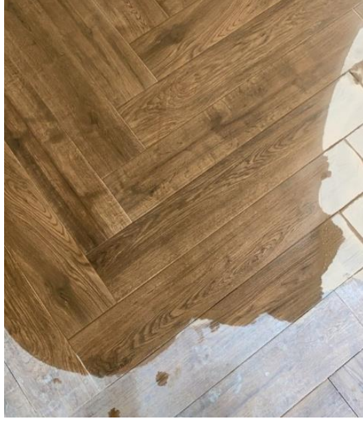
Şekil 9. Vernik işlemleri yapılan masif parke zemin kaplaması
