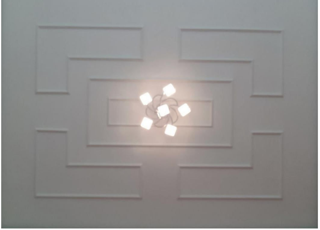
Şekil 78. H.Ç. Evi, tavanda lake boyalı MDF çıtalarla estetik bir görünüm vermek amacıyla yapılmış çıta uygulaması
