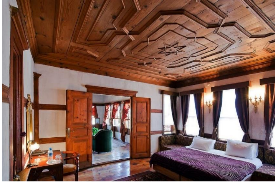
Şekil 10. Doğal ahşap malzemedeki yapılmış tavan kaplaması örneği
