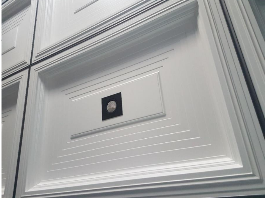
Şekil 79. Konya Satış Mağazası, lake boyalı MDF levhalarla oluşturulmuş tavan kaplaması
