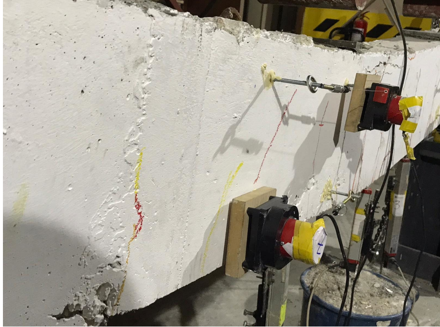
Şekil 26. CJ90 kirişi derz yüzeyi çatlak durumu
