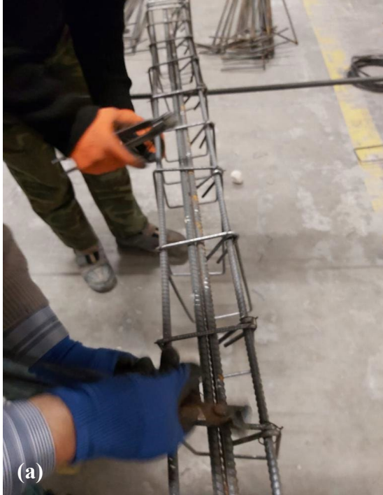
Şekil 8. Kiriş donatıları (a) hazırlanma aşaması (b) tamamlanmış hali
