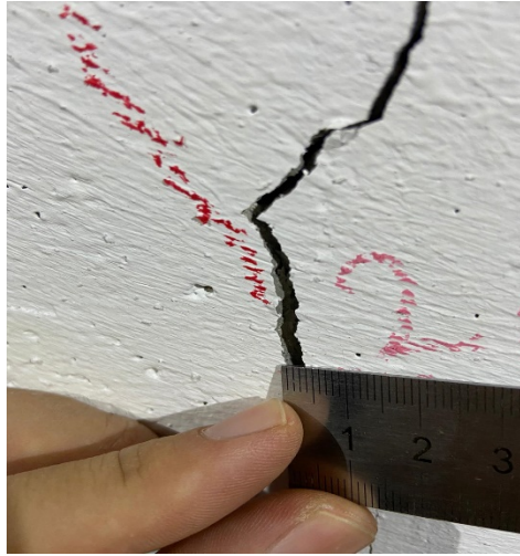
Şekil 18. Ref-2(Unconfined) kiriş numunesi çatlak genişliği
