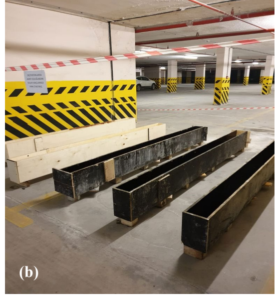
Şekil 7. Kiriş kalıpları (a) hazırlanma aşaması (b) tamamlanmış hali
