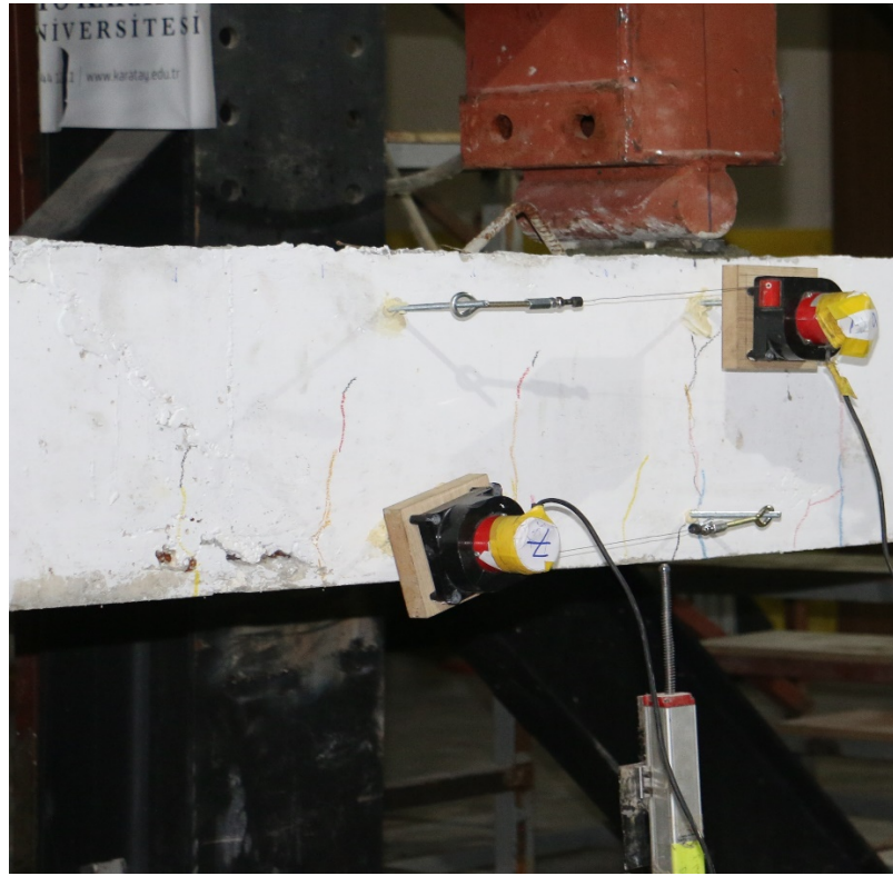
Şekil 34. CJ45 kirişi numunesinde soğuk derz birleşim yerinde oluşan çatlaklar
