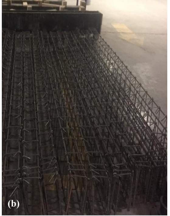
Şekil 8. Kiriş donatıları (a) hazırlanma aşaması (b) tamamlanmış hali
