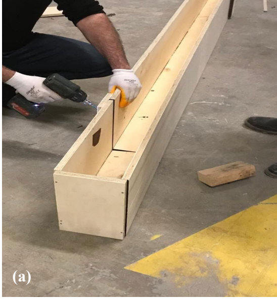
Şekil 7. Kiriş kalıpları (a) hazırlanma aşaması (b) tamamlanmış hali
