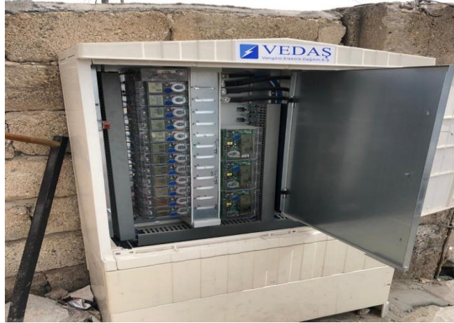
Şekil 6. Yatay sayaçlı ASOP Box pano.
