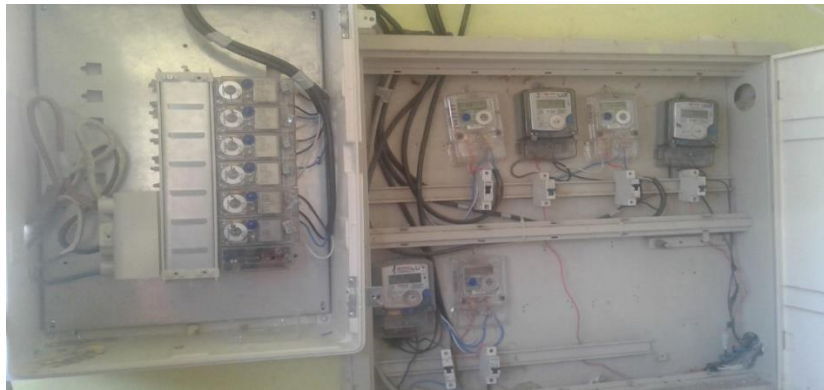
Şekil 5. Çok katlı binalarda yatay sayaç elektrik panosu değişimi.
