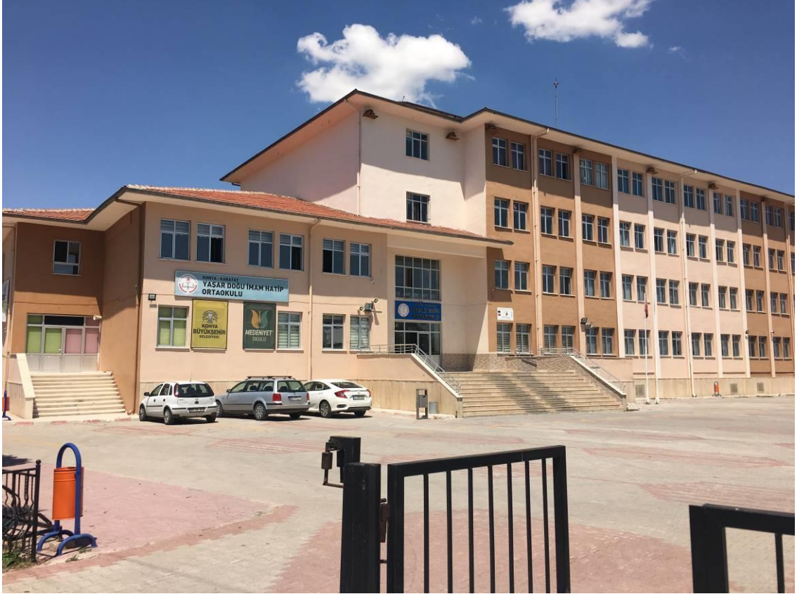
Şekil 60. 2012'de yapılan ortaokul binası ve yan tarafında girişi bulunan eski anaokul binası, 2019,Konya.
