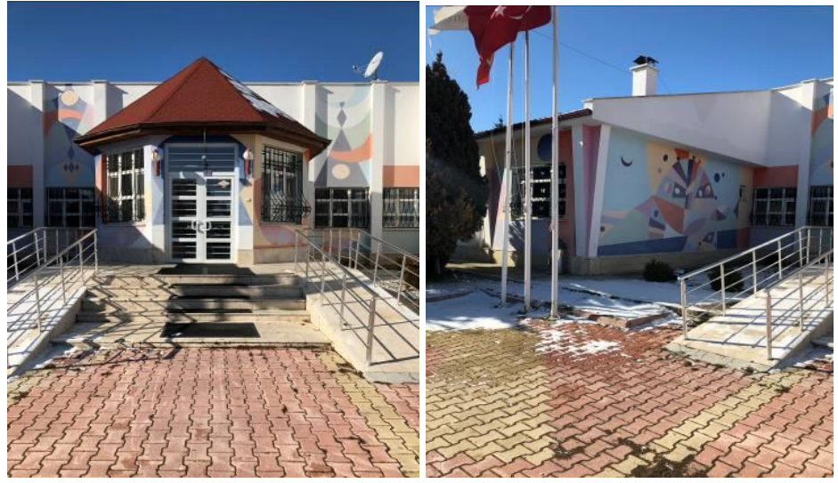
(r) Anaokulun giriş cephesi
