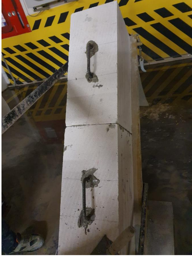
Şekil 26. GB3 duvar örümü aşaması
