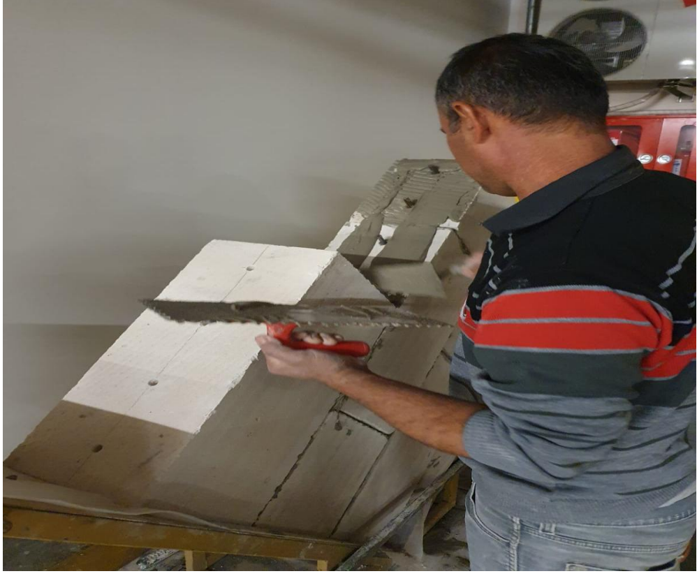
Şekil 22. GB1 duvar örümü aşaması
