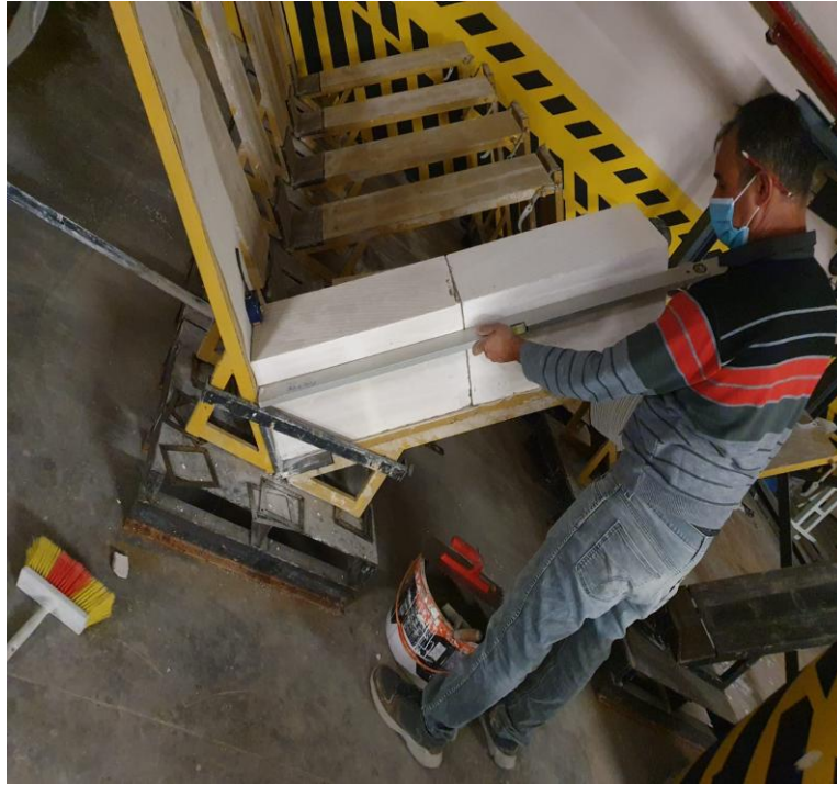
Şekil 19. GBS duvar örüm aşaması
