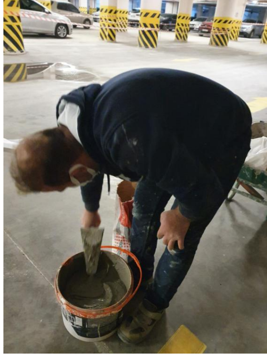
Şekil 18. Gazbeton yapıştırıcısının hazırlanması
