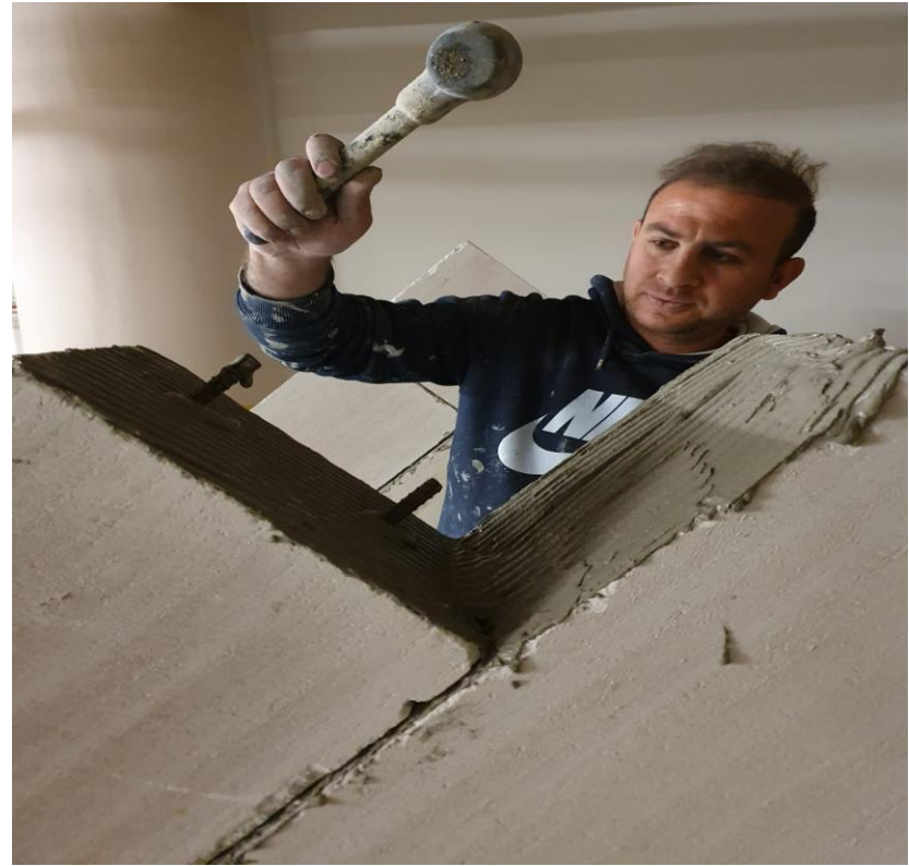
Şekil 24. GB2 duvar örümü aşaması
