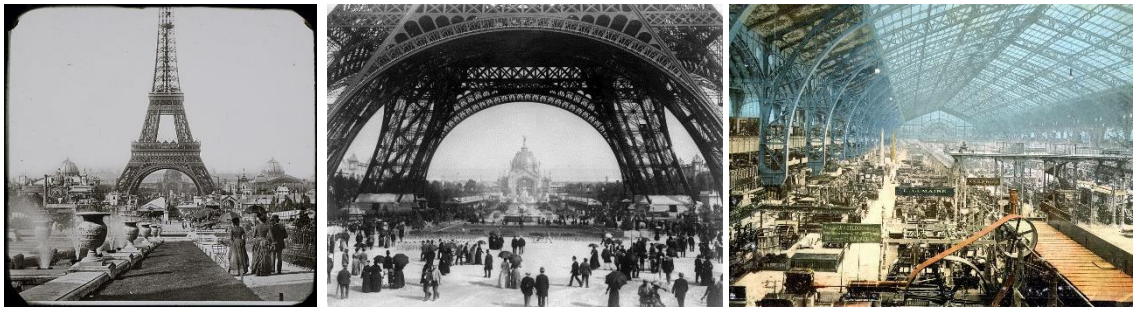
Şekil 48. Eiffel kulesi ve makine galerisi iç mekânı, Fransa
