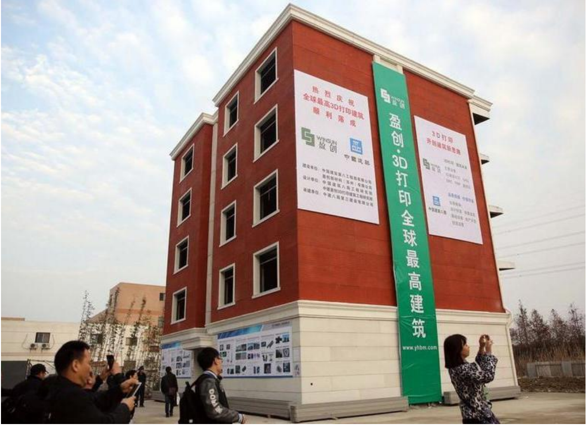
Şekil 2.3. 3 boyutlu baskı teknolojisiyle üretilmiş 5 katlı apartman projesi (Web Adresi 4)
